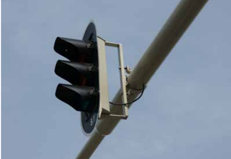
windvormfactor van een verkeerslantaarn met achtergrondschild: 1,32
