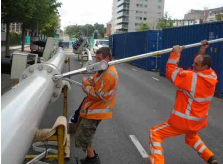
bevestigingsmaterialen aandraaien met een momentsleutel
