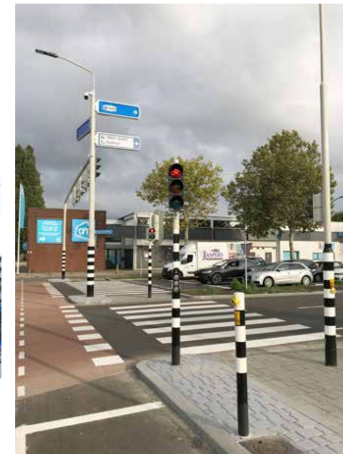
ondersteuningsconstructies voor verkeersregelininstallaties
