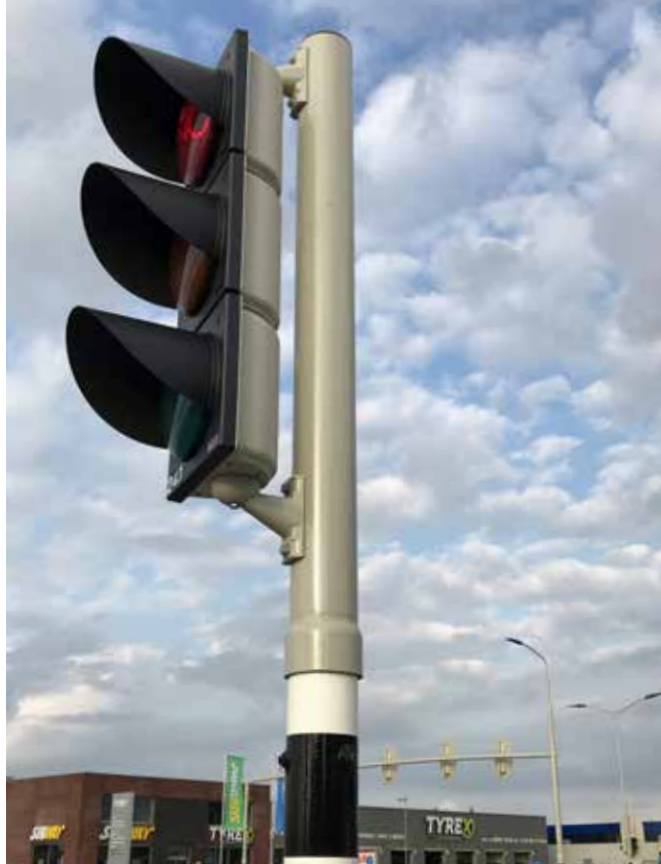
verkeerslantaarn aan-mast-montage middels opzetstuk
