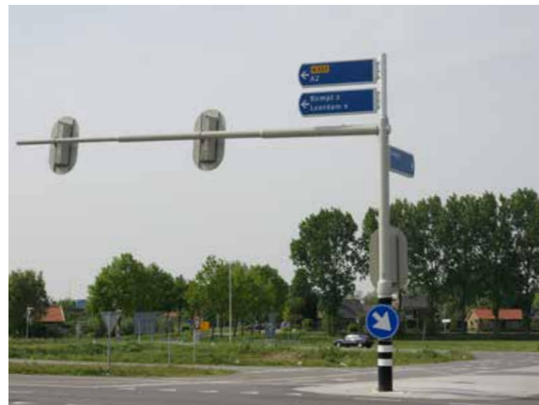
uithoudercombinatie gecombineerd met bewegwijzering
