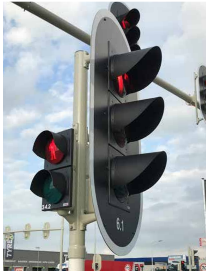
opzetstuk met verschillende formaten van verkeerslantaarns
