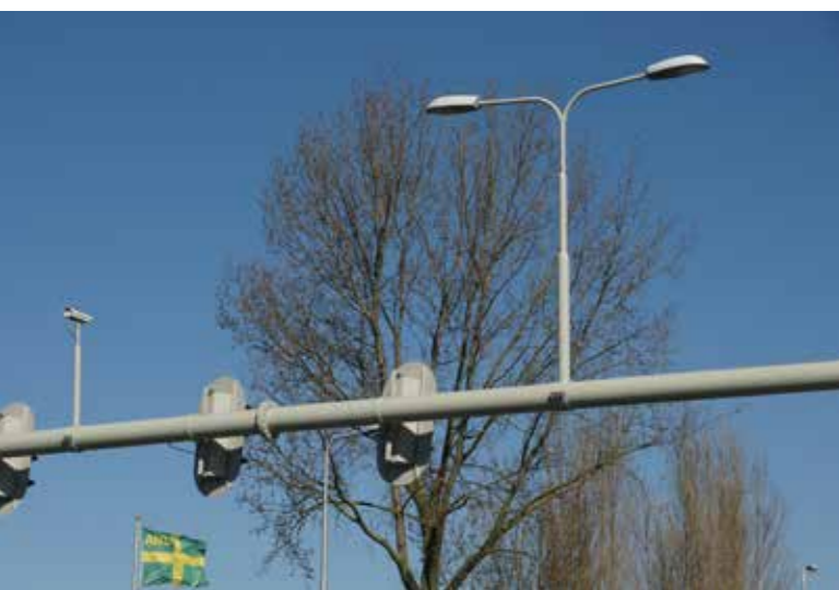
OVL-uitlegger in het midden van de portaalligger
