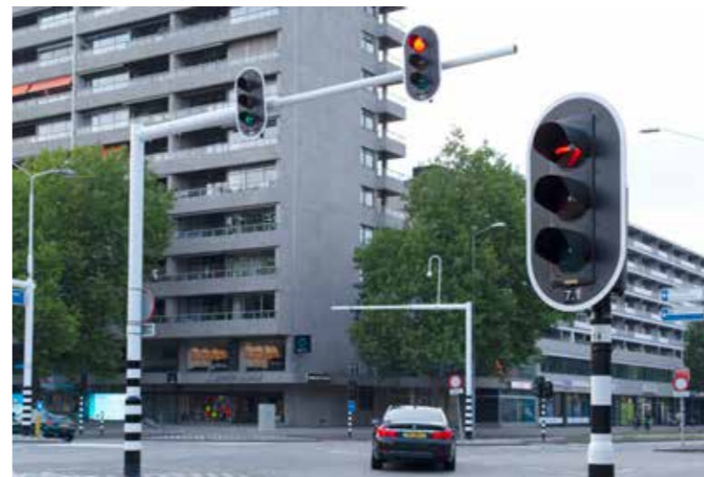
ondersteuningsconstructies voor verkeersregelininstallaties
